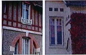
Façade en enduit mouchetés et faux pans de bois
