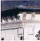
Corniche et bandeau en pierre
