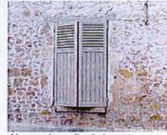
Maçonnerie moellon à pierre vue
