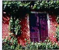
Brique recouverte d'un lait de chaux
