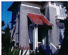
Entrée avec auvent en tuile mécanique
