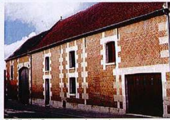
Réutilisation d'une grange en logement
