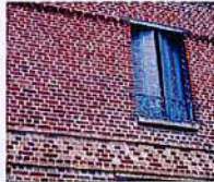
Brique rouge, brique silico-calcaire blanche
