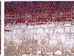
Brique et moellon calcaire
