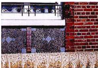
Modénatures : céramiques, bandeaux, corniches, harpes, encadrements
