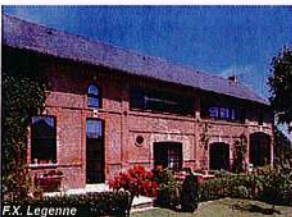
Rénovation d'une grange du XIX ème siècle en habitation conservant la volumétrie initiale et le parement brique
