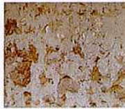
Enduit ancien sur moellon
