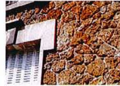
Meulière avec joint creux au mortier bâtard
