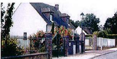
Clôtures construites avec les matériaux locaux : murets de brique rouge surmontés de ferronneries
