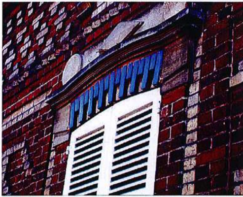
Brique rouge, silico-calcaire, vernissé bleu
