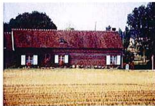
Longère en brique réhabilitée
