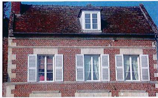
Maçonnerie mixte, volets peints persiennés
