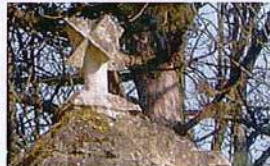
Pinnacle en pierre au dessus d'un puits
