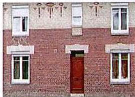
Mur en brique rouge et silico-calcaire
