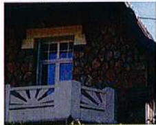
Balcon en béton d'une maison en meulière
