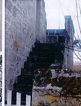
Escalier en pierre sur pignon
