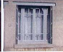
Baie avec linteau et volets métalliques pivotants
