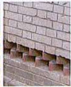
Jeux de brique créant une aération
