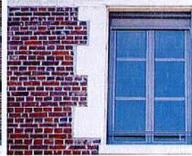
Ravalement de mur de brique, joints à la chaux avec un appareillage panerresse/boulisse, occultation par un store intégré
